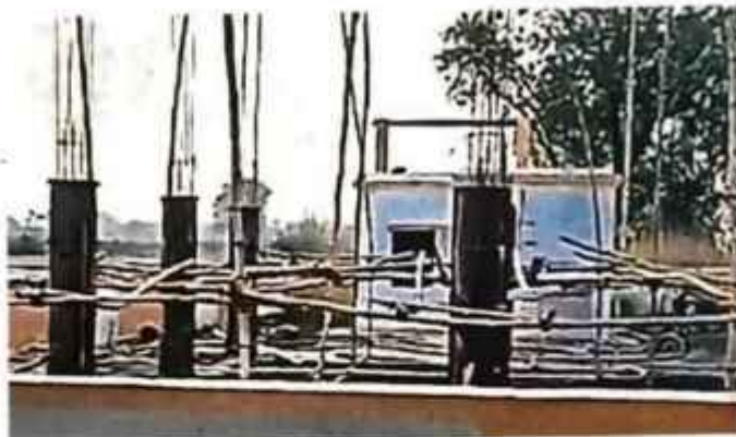
अभियांकला में निर्माणाधीन पानी की टंकी • जगरण
