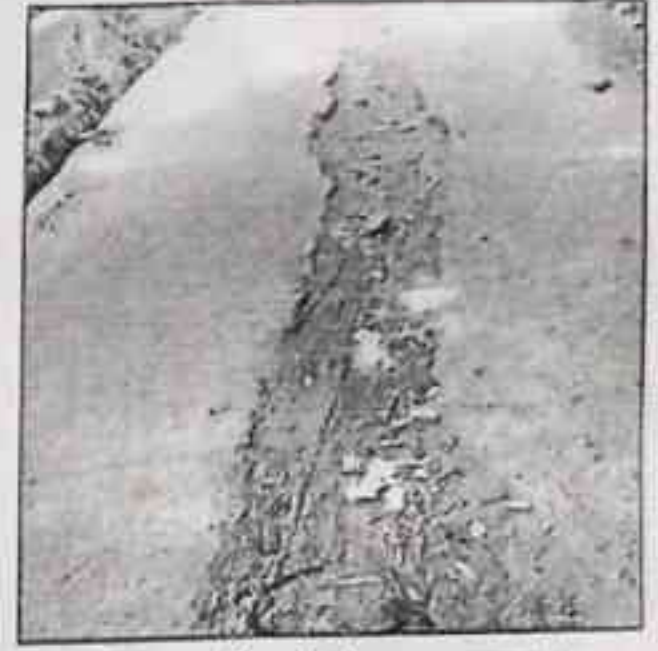
पाइपलाइन बिछाने के बाद सड़क। संवाद
