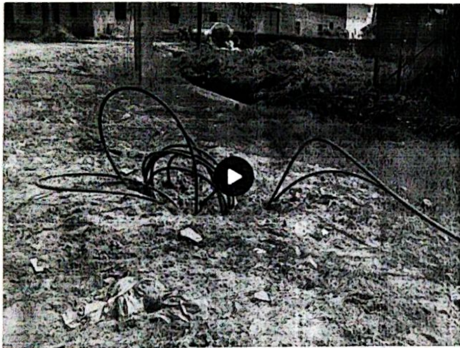
जल जीवन मिशन की खुदाई से गली बदहाल।
